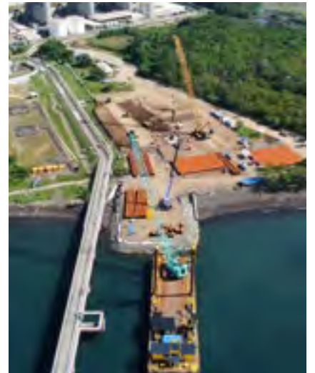
Batangas LNG Terminal, Philippines
